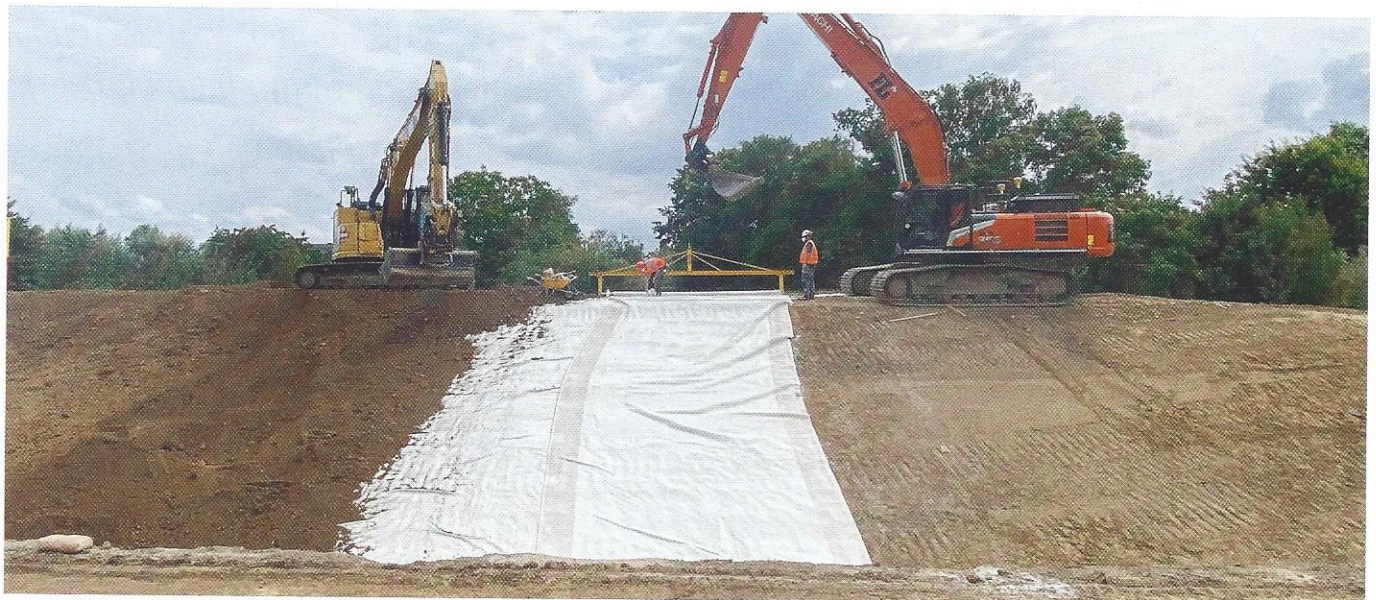
De bentonietmat wordt in Beesel in de kering gelegd
